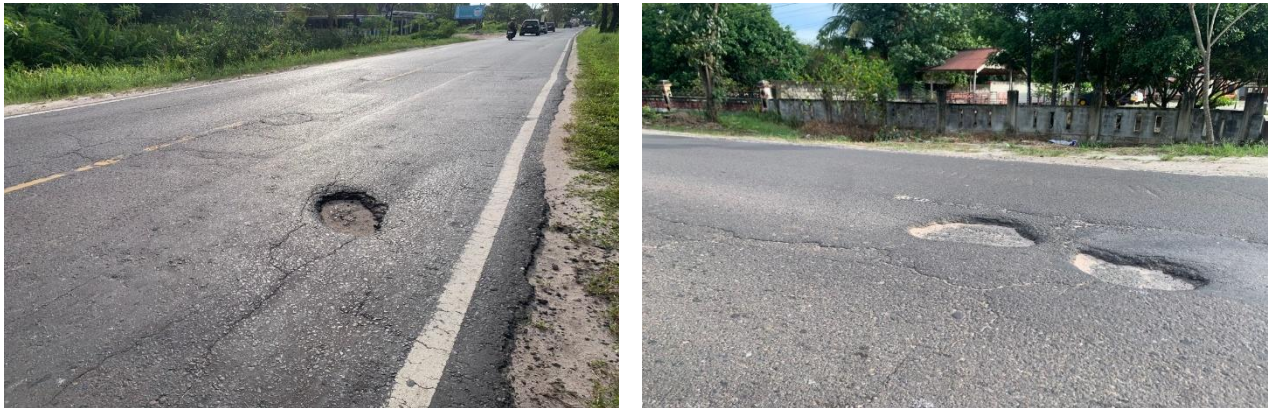
Gambar 1. Kondisi Kerusakan Jalan pada Ruas Jalan Trans Kalimantan Km. 10–14
